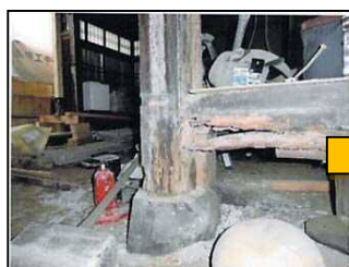
柱の劣化部分の修繕
