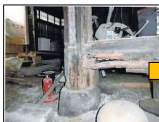
柱の劣化部分の修繕
