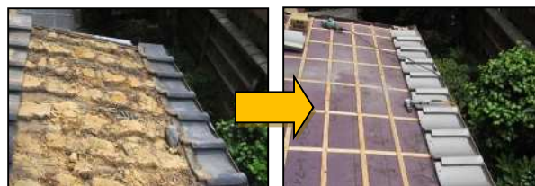
屋根の軽量化（葺き土を撤去する工事）
